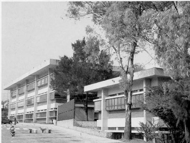
Centro Escolar del Lago. Edificio central.
