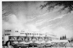
Albergue Trinitario, exterior.
