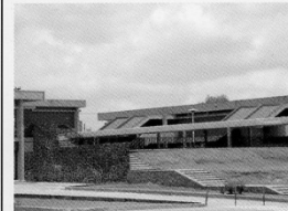
Centro Escolar del Lago. Detalle.
