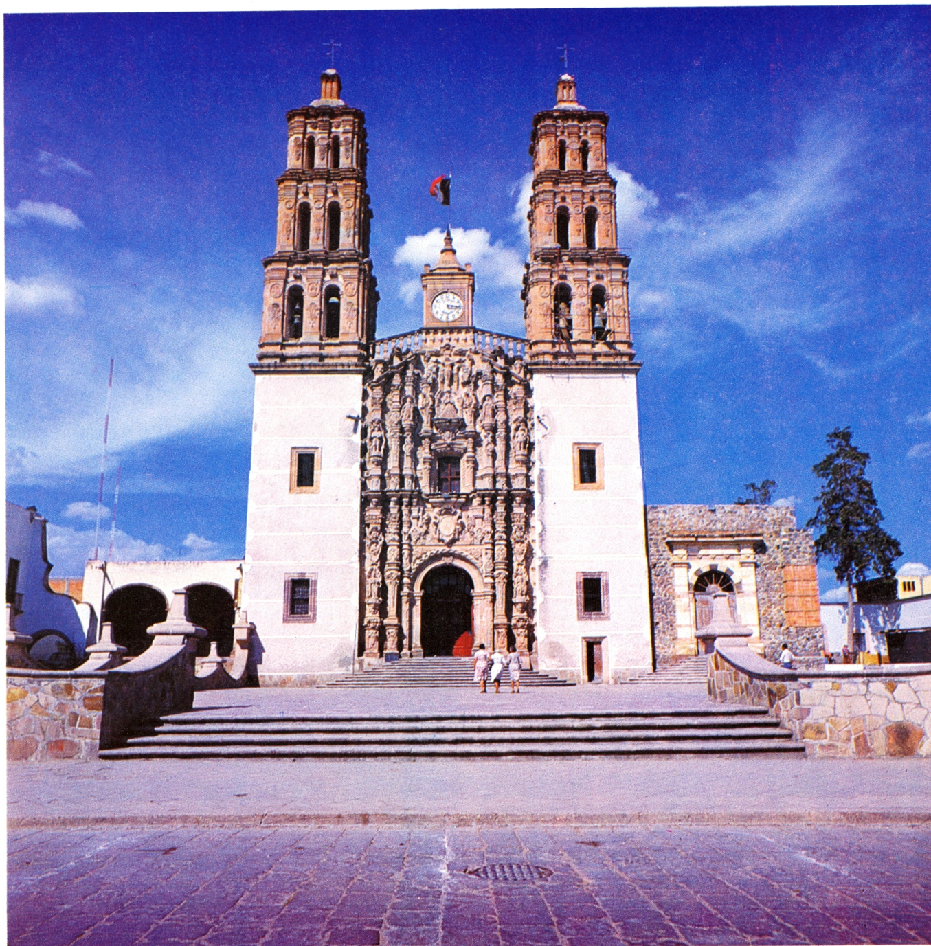
Fachada principal de la Parroquia.
