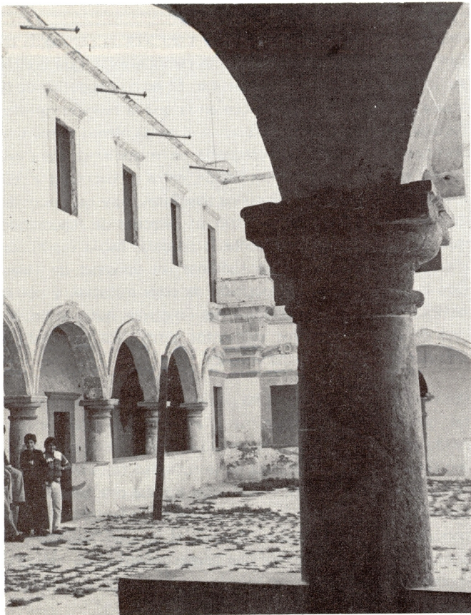
Ex. Convento de San Felipe Neri. San Miguel de Allende, Guanajuato. Vista del claustro. Actualmente funciona como escuela secundaria.
