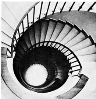
Detalle de la escalera.
