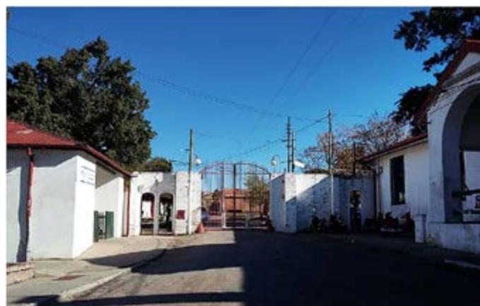
Figura 11. Estado actual del portón de acceso principal al exfrigorífico. Fuente: Fotografía de Mauro Delgrosso, 2016.
