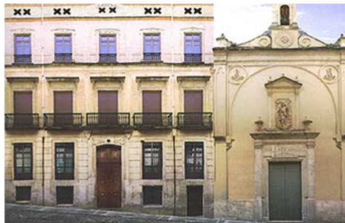
Figura 4. Real Fábrica de Paños. Construida en 1790 en el centro de Alcoy. Fuente: Agrupación Empresarial Textil Alcoyana.
