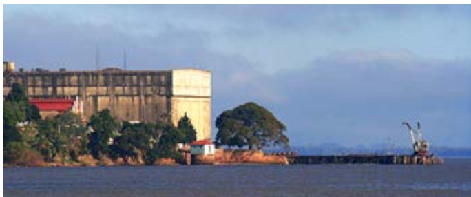
Figura 1. Vista de las cámaras frías del frigorífico, construidas a partir de 1921.
