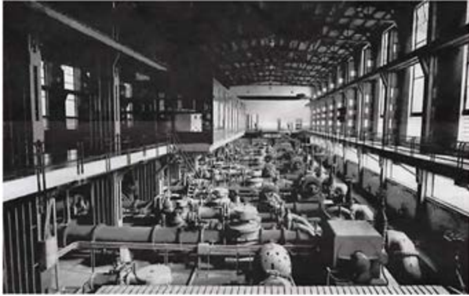
Figura 5. Interior de la casa de bombas Xotepingo. Fuente: reverso de un recibo de agua del Sistema de Aguas de la Ciudad de México.
