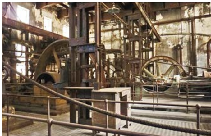
Figura 7. Sala de máquinas, Frigorífico Anglo del Uruguay, Fray Bentos. Fuente: Fotografía de Ubirajara Buddin Cruz, 2013.
