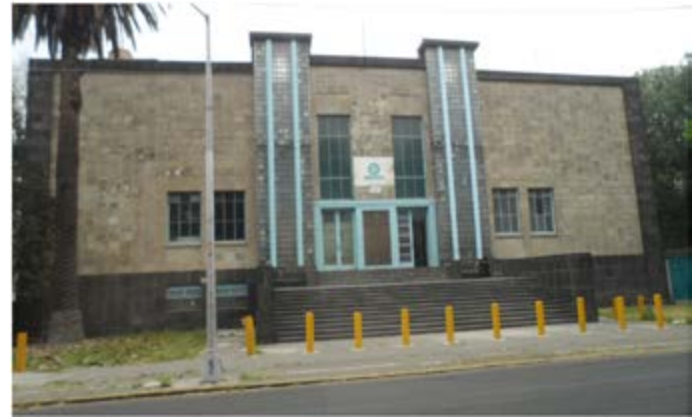
Figura 4. Casa de bombas Xotepingo. Fachada art déco . Foto del autor.
