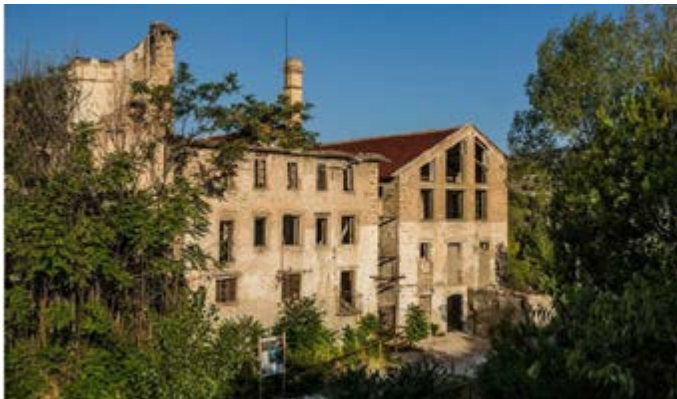
Figura 6. Estado actual del conjunto fabril formado por el Molí de Romualdet (sobre un batán del siglo XV, el edificio en ruinas a la izquierda de la foto), el Molí Nou del Ferro (con la chimenea) y el Molino de Soler Hermanos; en el espacio entre estos dos estaba instalada la rueda hidráulica impulsada por el río Molinar. Fuente: Miguel Lorenzo.
