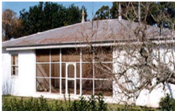
Figura 8. Chalet de los capataces (2005).
