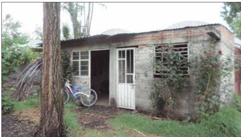
**FIGURA 36.** Ejemplo típico de casa en una chinampa con muros de block de cemento-arena, castillos y dalas de concreto, y cubierta de lámina que más tarde se podrá substituir por otra de concreto. Casi siempre son viviendas “progresivas” que se van ampliando y completando gradualmente.
