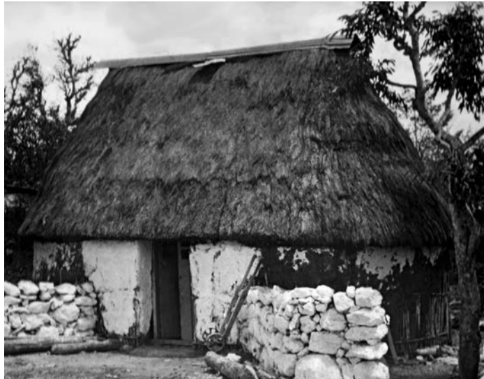
FIGURA 2 Vivienda maya de planta biabsidal. Muros de varas y barro, cubierta de palma, Yucatán.
