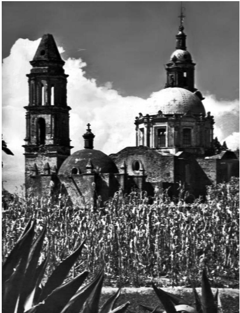
FIGURA 35 Capilla del barrio rural de San Pedro Tecamac. San Pedro Cholula, Puebla.
