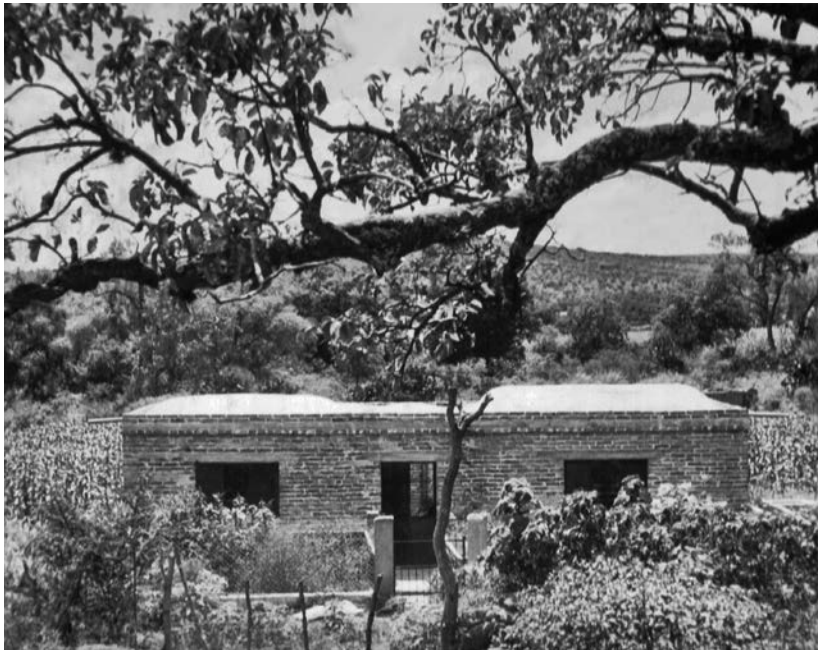
FIGURA 4 Vivienda rural de muros de bóvedas de ladrillo región de Lagos de Moreno, Jalisco.
