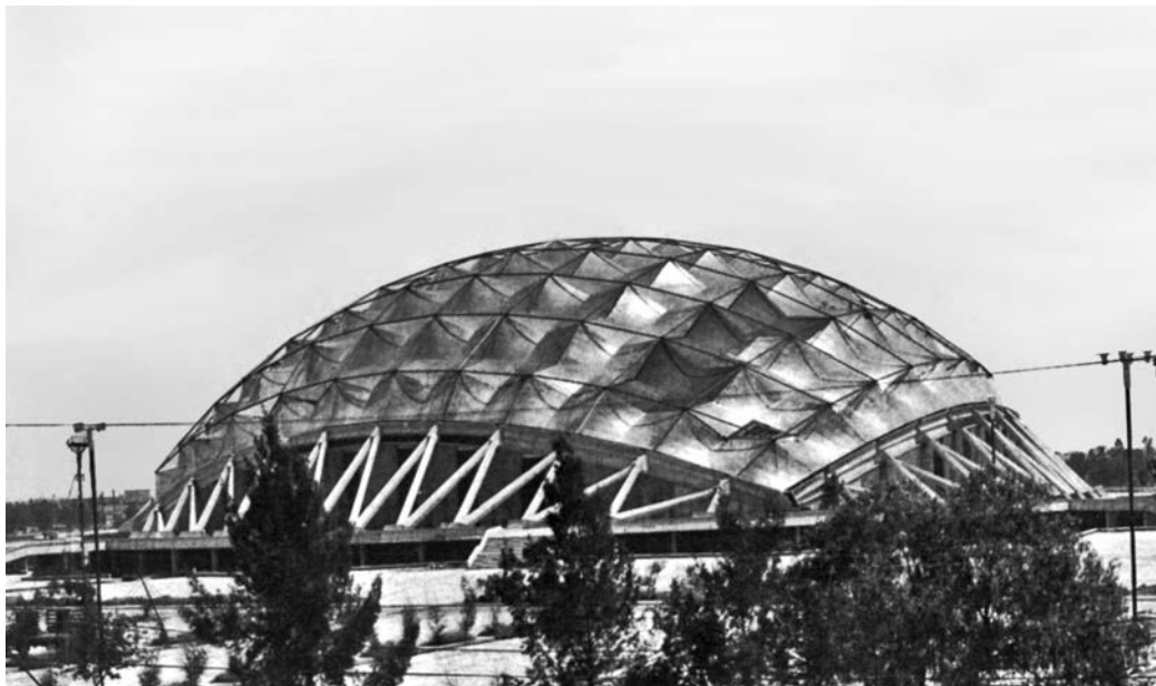
FIGURA 1 Palacio de los Deportes, México, 1968. Félix Candela, Enrique Castañeda y Antonio Peyrí, arquitectos. Fuente: Z.S. Makowski, “Structures Spatiales, bilan et tendances”, en Techniques & Architecture Núm. 320, Paris, 1978.
