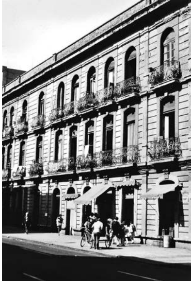
FIGURA 5 Edificio de departamentos en las calles de Perú, con pocos deterioros. Foto: AGP.
