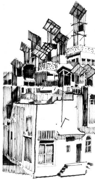
FIGURA 9 Viviendas en Hyderabad, Paquistán. Los salientes sobre las azoteas “atrapan la brisa” y la llevan al interior del edificio, apoyando la formación de un microclima confortable en esta región tórrida.
