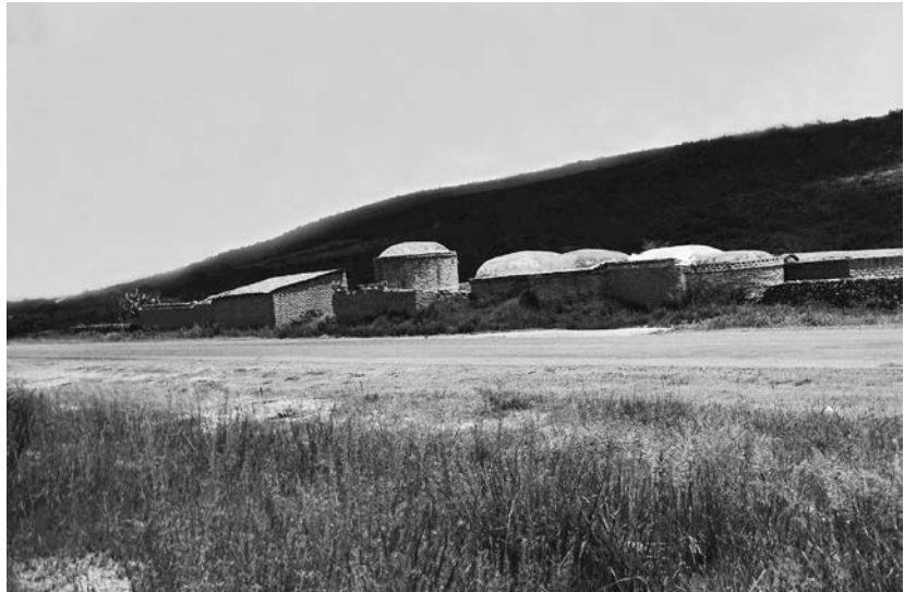
FIGURA 11 Trojes en un rancho. Muros y bóvedas de ladrillo. Región de Lagos de Moreno, Jalisco.
