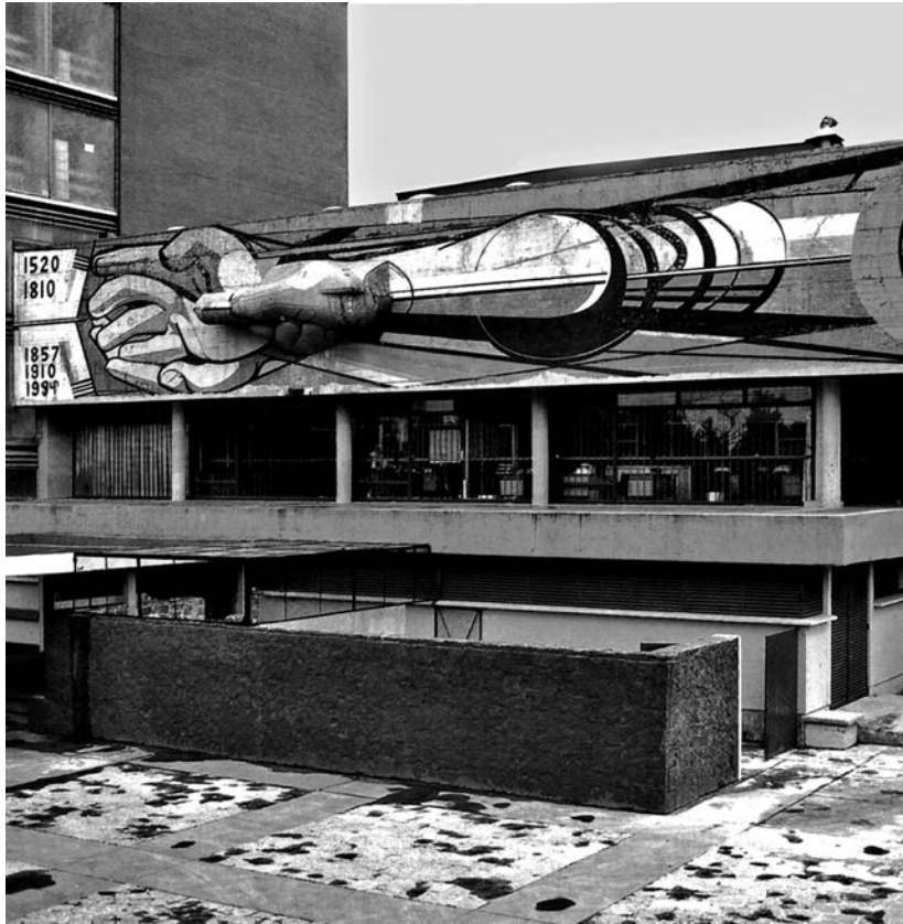
FIGURA 1 Rectoría de Ciudad Universitaria, México, 1954. Arqs. Mario Pani, Enrique del Moral y Salvador Ortega Flores. Escultopintura integrada al cuerpo bajo del edificio. Autores: David Alfaro Siqueiros con la colaboración de Federico Canessi. Fotografía de Mariana Yampolski, 1995.
