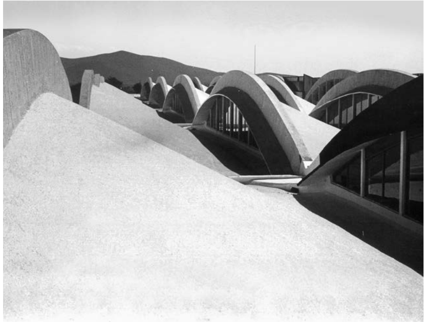
FIGURAS 3 Y 4 Fábrica Sidi en Cuernavaca, Mor., 1964. Arquitectos: A. González Pozo y L. Vilchis Platas. Consultor: J. A. Tonda. Conoides de concreto de 4 cm de espesor para 22 m de claro. Fotos: AGP.
