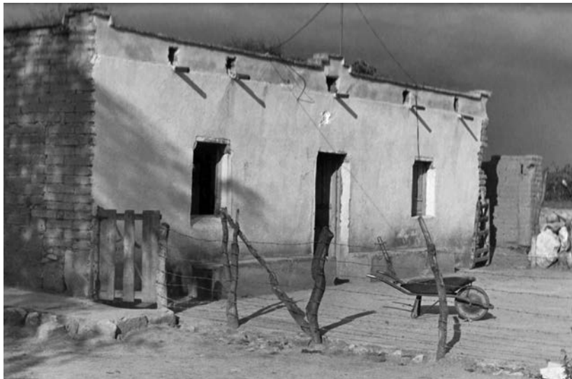
FIGURA 9 Vivienda de muros de adobe. Revocada con barro y cal; cubierta de terrado. Región de San José de Gracia, Aguascalientes.
