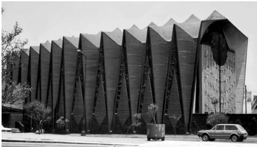
FIGURA 4 Iglesia en Xotepingo, vista de la nave desde la avenida. Foto: AGP.
