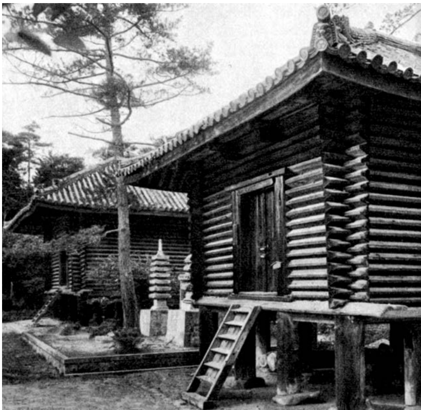
FIGURA 1 Y 2 La antigua tradición arquitectónica de la arquitectura japonesa en madera se reinterpreta en la arquitectura contemporánea en concreto armado. Sagrario en el Santuario de Toshodaiji, Nara, Siglo VIII d.C. y Hotel Honjima, Japón, Noriaki Kurokawa, arquitecto. Fuentes: William Alex, Japanese Architecture , Georg Braziller, New York, 1963 y Arquitectos de México No. 25, México, 1966.
