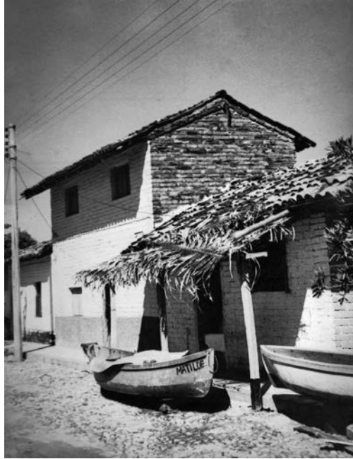
FIGURA 1 Vivienda urbana de un pescador. Muros de ladrillo y cubierta de tejado. Puerto Vallarta, Jalisco.
