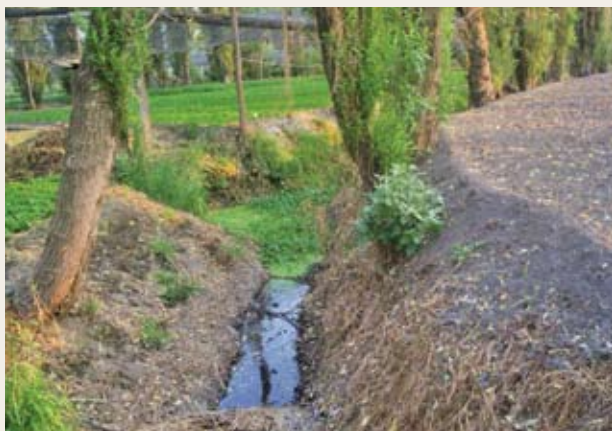
FIGURA 55. Apantle muy angosto y con cauce insuficiente para navegarlo. En primer término se ve su término hasta el tramo donde ya está cegado.
