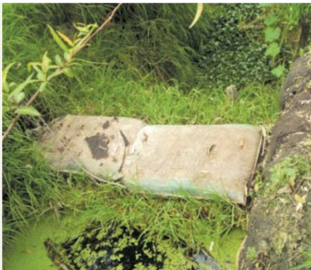
FIGURA 53. Costalera sencilla, para evitar que el agua fluya demasiado rápido hacia la zona norte, más baja por hundimientos diferenciales. Los costales se llenan de arena.
