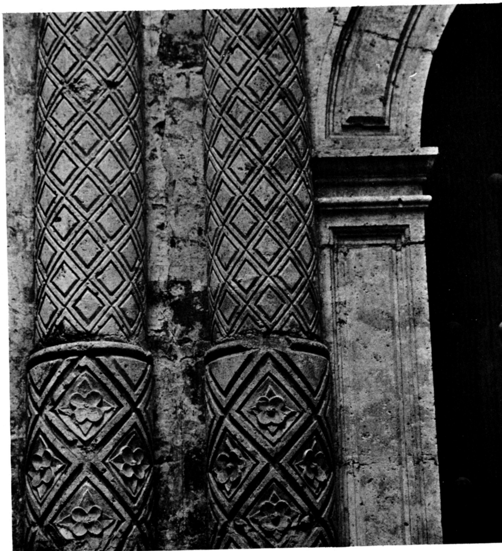
Columnas tritóstilas y jamba en la portada lateral.
